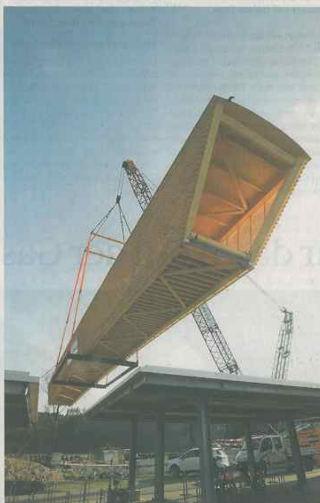
Problemlos hebt der Riesenkran die 116 Tonnen schwere Brücke.
